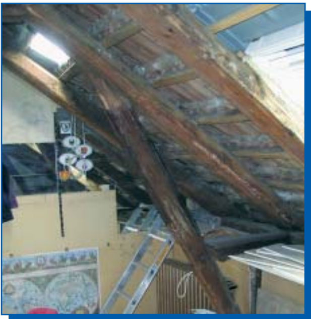
Dachgeschoss – vor dem Umbau
